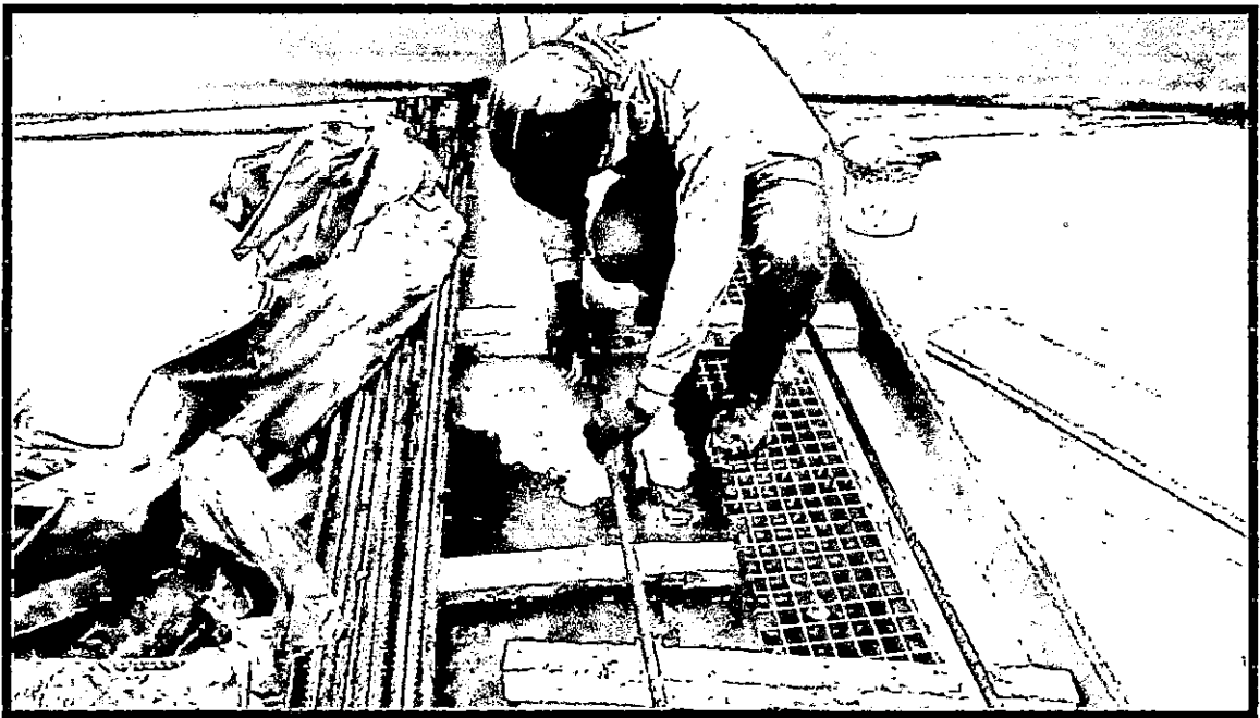
HABILITACIÓN DEL ACERO CORRUGADO FY=4200 kg/cm 2 EN LOSAS ARMADAS
