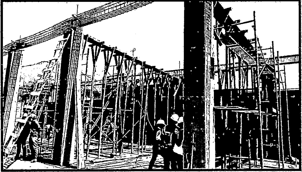
HABILITACION DE ACERO FY=4200 kg/cm 2 EN VIGAS
