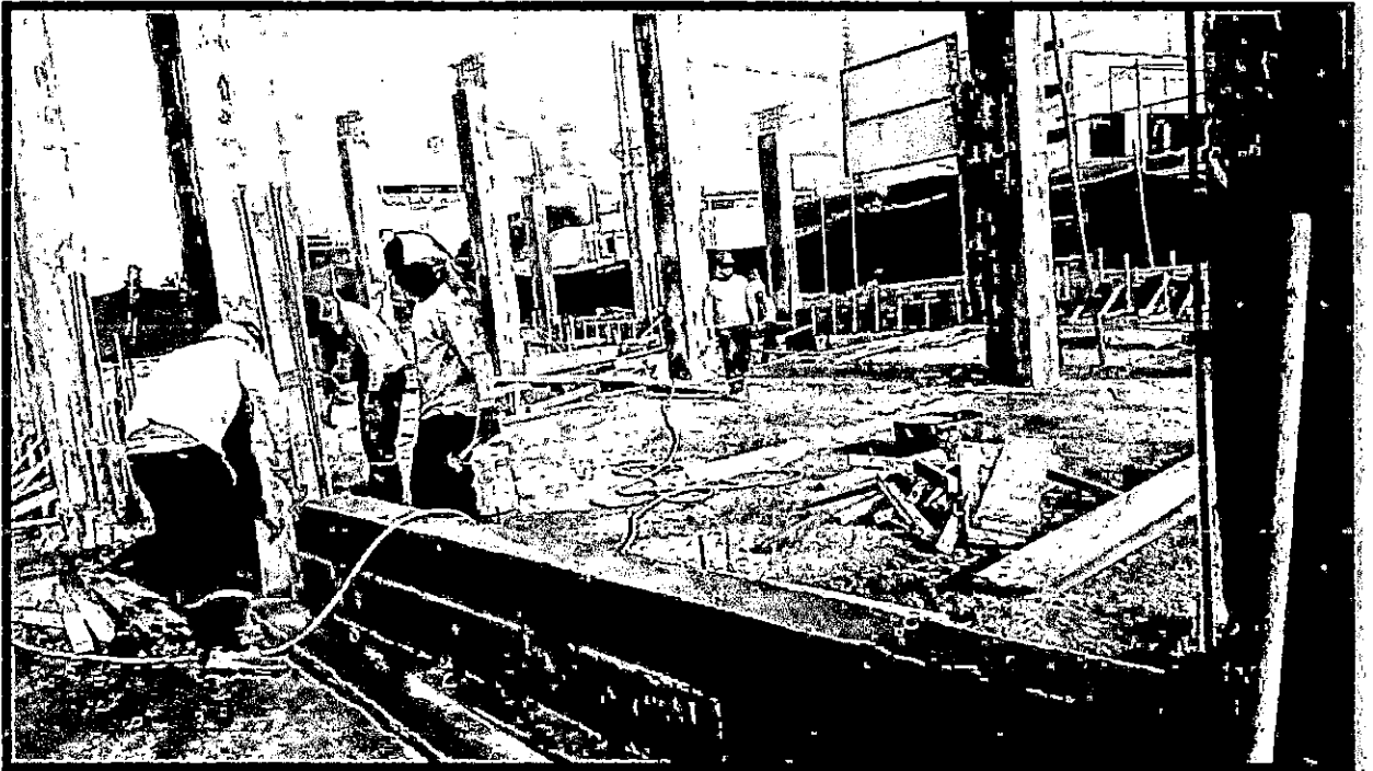
DEENCOFRADO DE SOBRECIMENTOS
