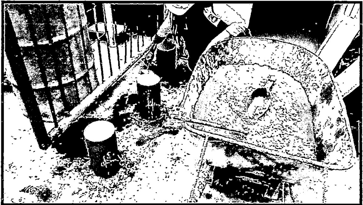
OBTENCIÓN DE TESTIGOS DE CONCRETO PARA CONTROLES DE CALIDAD DE SOBRECIMENTOS f'_c=175 \text{ kg/cm}^2
