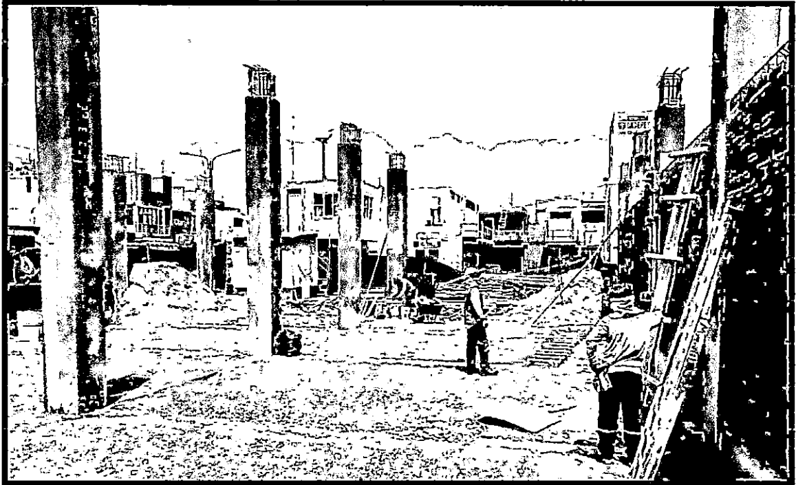
COLUMNAS DE CONCRETO ARMADO f'_c=210\text{kg/cm}^2
