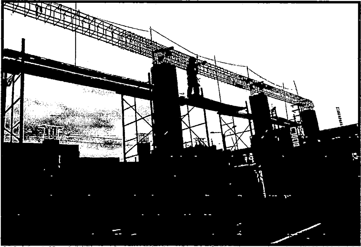
HABILITACIÓN DE ACERO FY=4200 kg/cm 2 EN VIGAS
