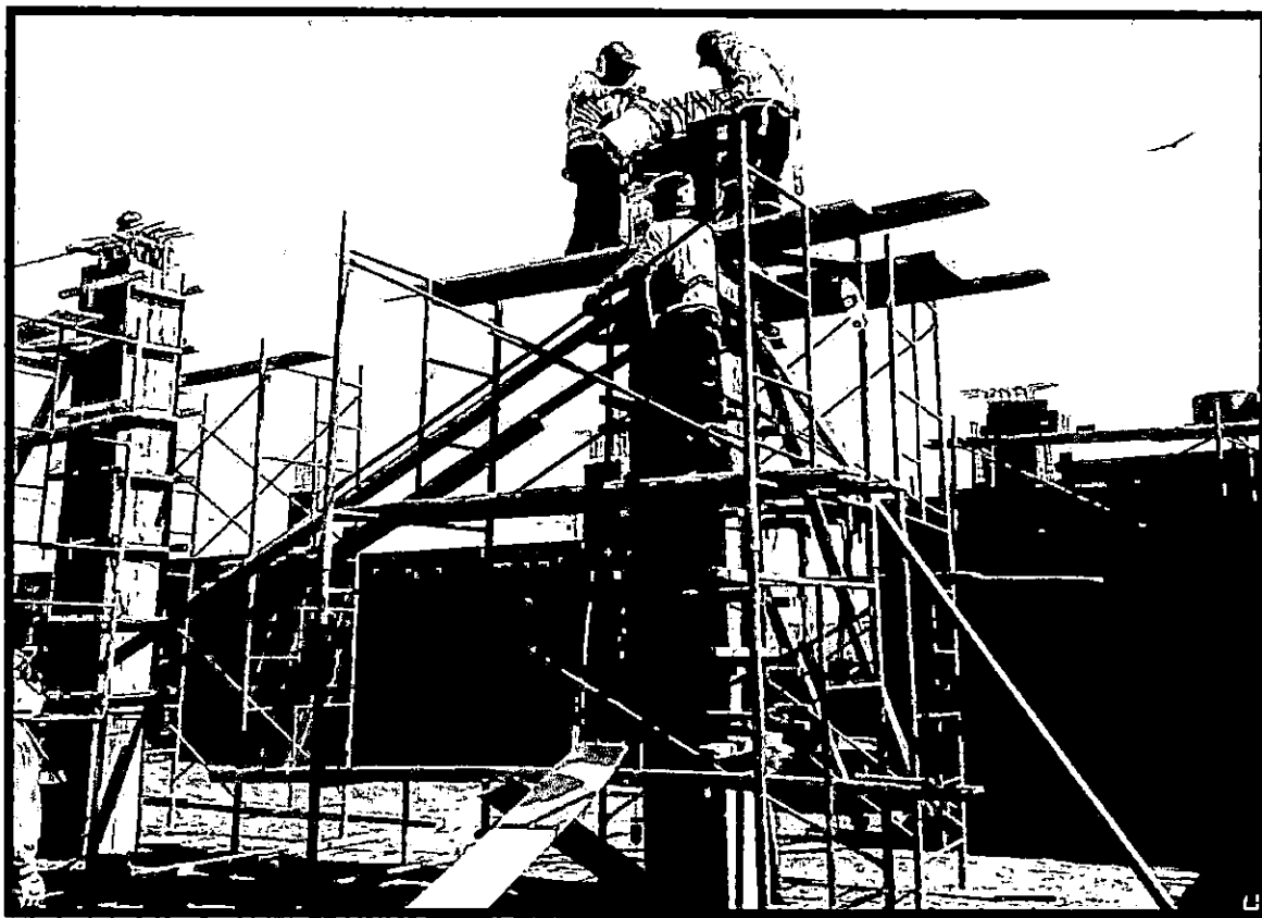
VACIADO DE CONCRETO f_c=210 kg/cm 2 EN COLUMNAS
