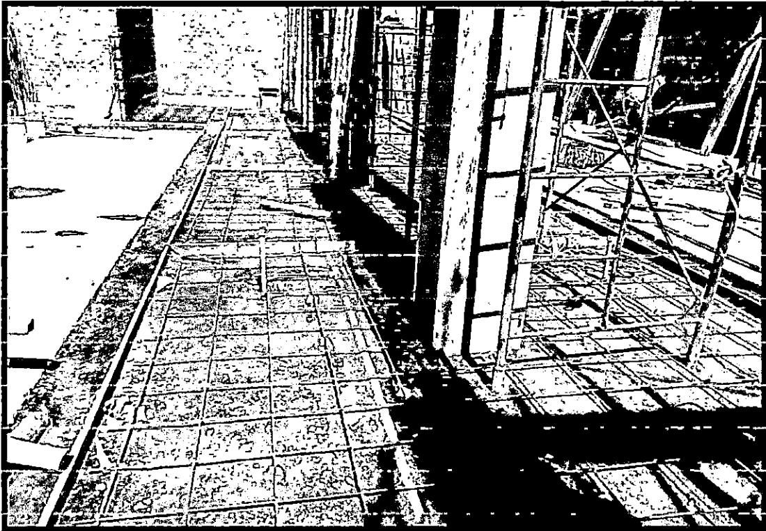
HABILITACIÓN DE ACERO FY=4200kg/cm2 EN LOSA ARMADA
