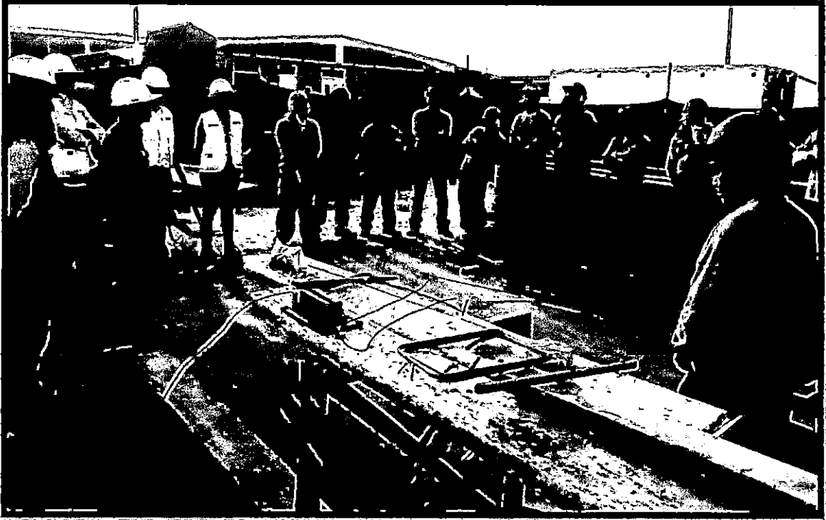
CAPACITACIÓN EN SEGURIDAD CON PARTICIPACIÓN DE LA SUPERVISIÓN EN OBRA
