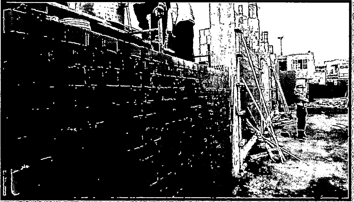
MUROS DE LADRILLO E=25 CM
