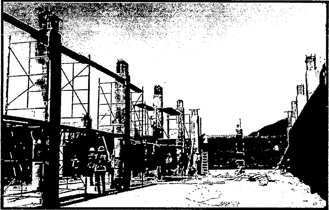
COLUMNAS DE CONCRETO ARMADO f'_c=210 kg/cm 2
